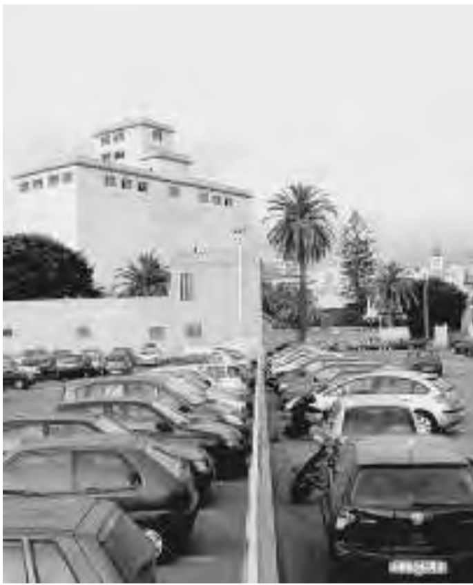
Sopra, l'ex semoleria dove dovrebbe sorgere il campus universitario e, a fianco, la casa dello studente di via Trentino
